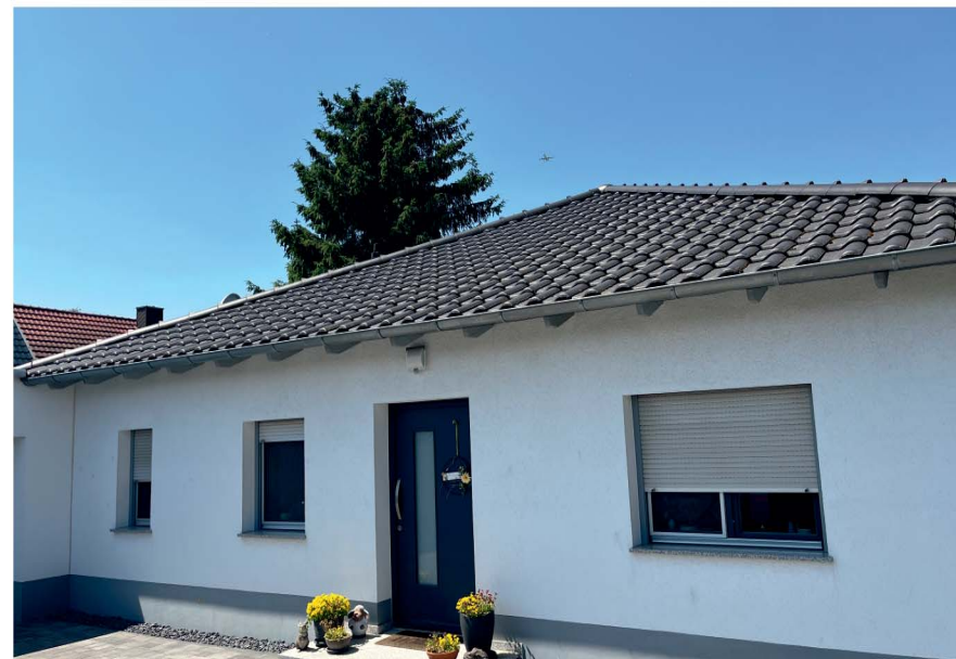
IP2 - Wohnhaus „Hallesche Str. 1B“, Aufpunkthöhe 1,5 m
