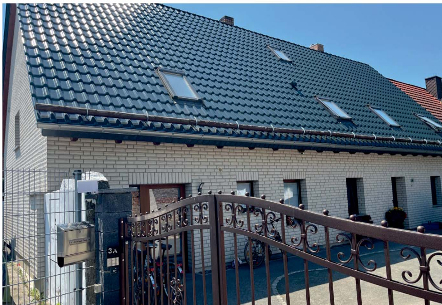
IP1 - Wohnhaus „Hallesche Str. 3A“, A-höhe 1,5 m und 4,0 m
